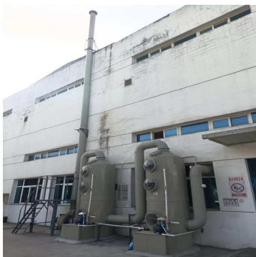
提取车间有机废气治理措施及 DA003 排气筒
