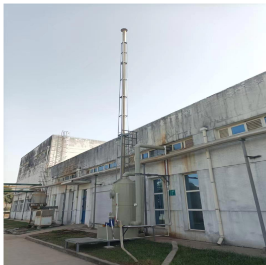
提取车间前处理工序颗粒物治理措施及 DA002 排气筒
