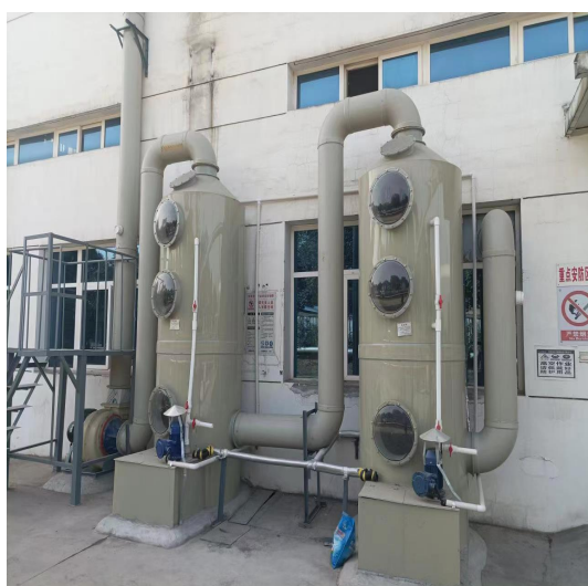
提取车间有机废气治理措施及 DA003 排气筒
