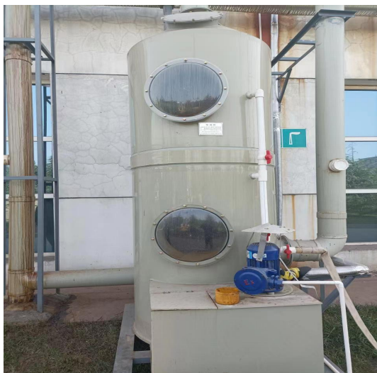
提取车间前处理工序颗粒物治理措施及 DA002 排气筒
